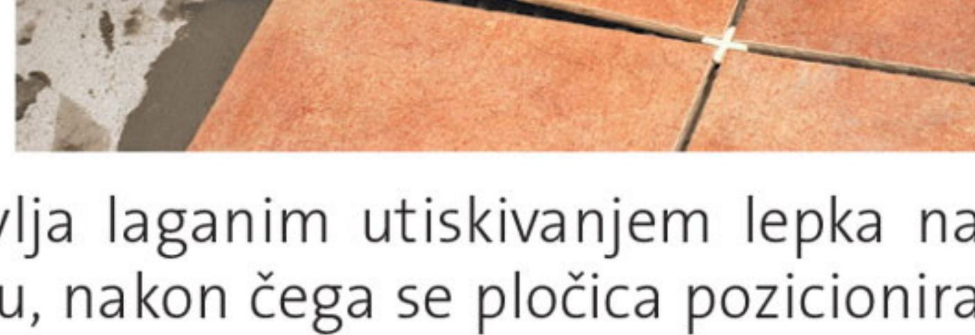
Postavljanje pločica se obavlja laganim utiskivanjem lepka na površinu, a zatim i na pločicu, nakon čega se pločica pozicionira i niveliše kucanjem gumenim čekićem, ili korišćenjem klinova i sistema za nivelaciju. Pločice se ne smeju otresati na podlogu. Prilikom polaganja pridržavajte se širine fugne koju je dao proizvođač, mi preporučujemo 2mm za zidne i 3mm za podne pločice. Kao pomoćno sredstvo koristi se krstić za postavljanje pločica.
